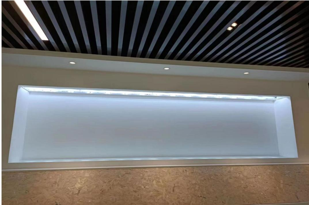
方案 A：框内部上下面轨道安装
